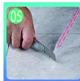
05 Наклоненный нарезать верхнюю часть сопла в 45 °.
